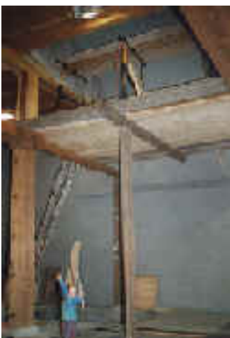
Ein zweiter Boden wird verlegt
